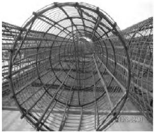
图 3 桩端注浆管道(改造后)
