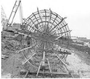
图 2 桩端注浆管道(改造前)
